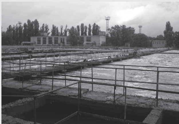
ボルトニッチ下水処理場の全景
