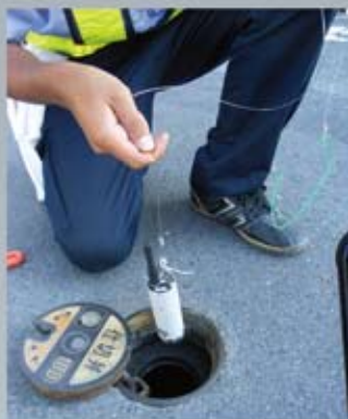
ロガー設置作業
