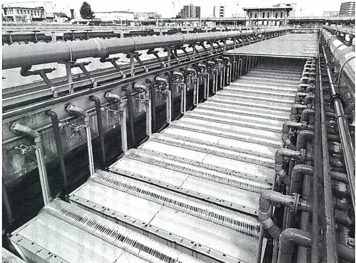
日本最大の膜処理施設 堺市三宝下水処理場(関連記事:土木学会誌2011年9月号、4～5ページ)
