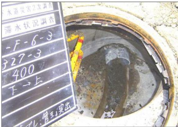
写真-1 管きよの突出被害の例
