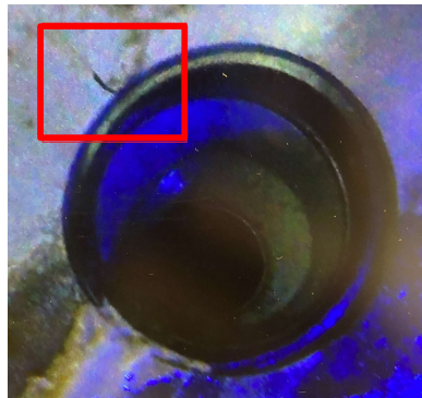
②取付管接合部における破損
